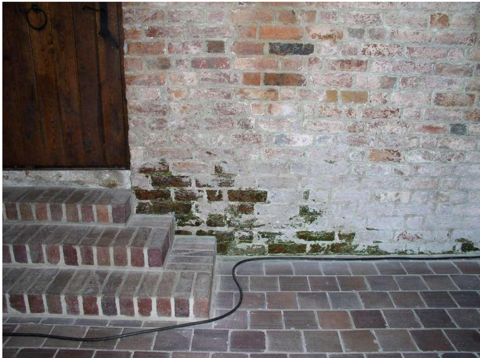
Schadensbilder an den Gewölbedecken, Innen- und Außenwänden durch eindringende Feuchtigkeit
