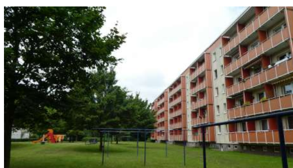
Abb. 16: sanierte Plattenbauten Knieper West I
