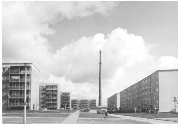
Abb. 12: Willi-Bredel-Straße (WK I) mit Heizwerk
