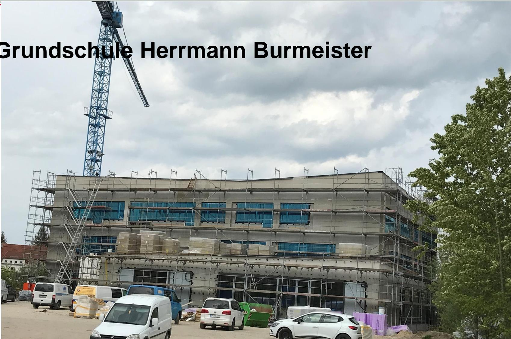
Derzeit laufen die Arbeiten der Fassade des Gebäudes. Bis auf den Bereich der Mensa sind weitestgehend alle Gebäudeteile verkleidet. Parallel dazu laufen die Rohinstallationen TGA und Trockenbau. Im Einzelnen führten/führen Lieferschwierigkeiten u.a. beim Stahl zu den Verzögerungen. Derzeit wird mit einer Fertigstellung im I. Quartal 2023 gerechnet
